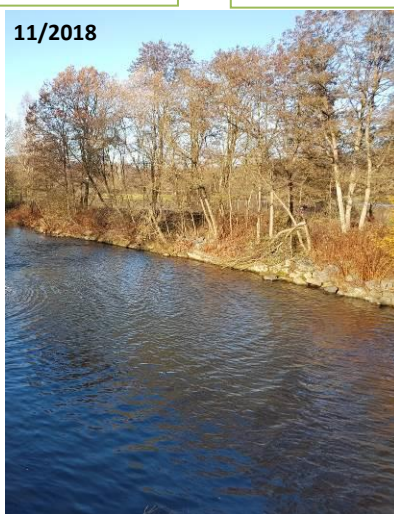
Enrochements à Lachapelle
