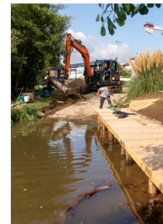
Réfection de la rampe de mise à l'eau à l'étang de Pont-à-Mousson avec création d'un quai
