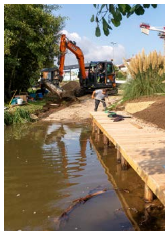
Refection de la rampe de mise à l'eau à Pont-à-Mousson avec création d'un quai
